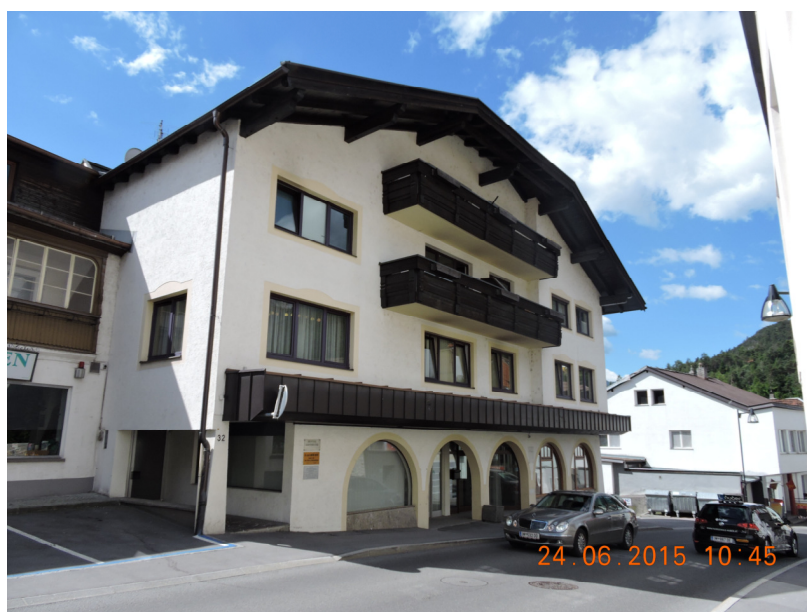
Bild unten: Außenansicht Gebäude, das Geschäftslokal befindet sich auf der linken Seite
